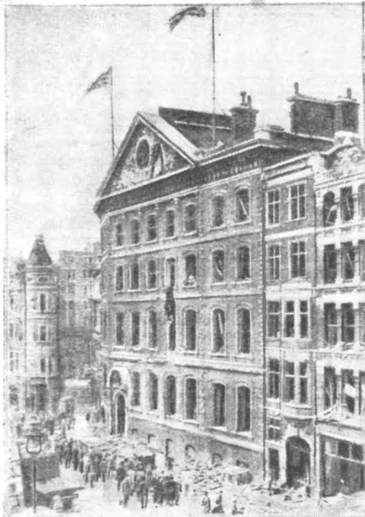
Здание газеты «Таймс» после бомбардировки. Одна из бомб попала в центр здания, причинив большие разрушения
